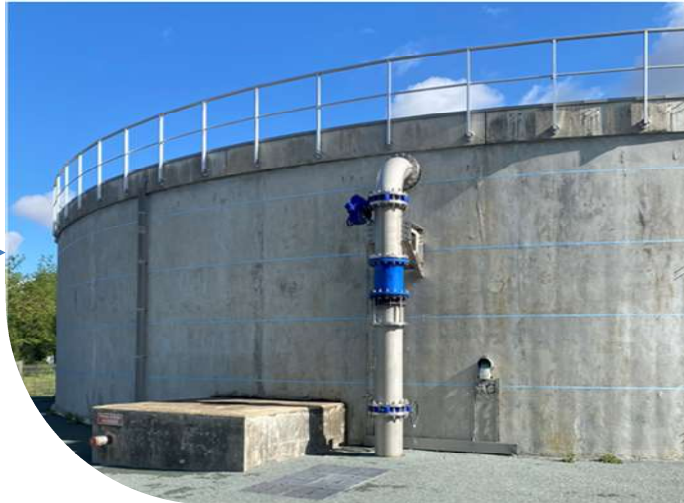
La conduite d'arrivée d'eau de secours est déjà installée à l'usine de Beaulieu
